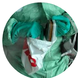
Stockage des filtres dans un sac hermétique
