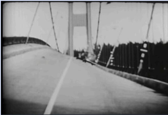
L'effondrement du pont de Tacoma en 1940 permet de bien visualiser un mouvement oscillatoire (causé ici par le vent) et le résultat que cela peut avoir sur une structure (cliquez sur l'image pour visionner le phénomène en vidéo).
