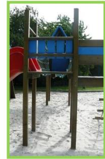
$$\text{Distance minimale d'écartement} = (2/3 * \text{hauteur de chute}) + 0,5\text{m}$$
