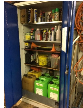
Exemple d'armoire avec des étagères distinctes, avec bacs de rétention
