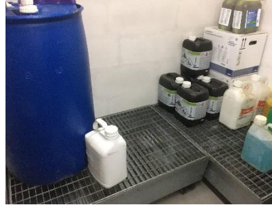
Exemple de bacs de rétention réalisés par un exploitant agricole
