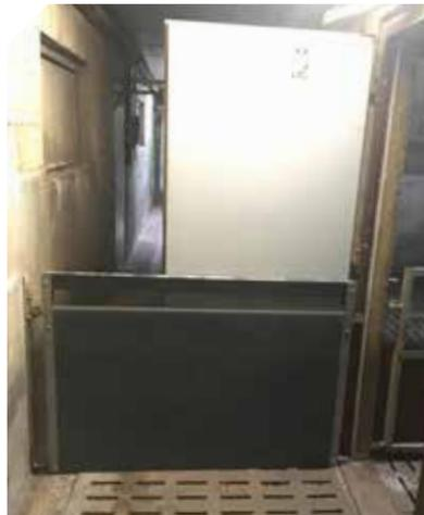
Le portillon réalisé à l'aide de cornières inox et panneaux recoupables permet de s'adapter facilement aux dimensions voulues.
