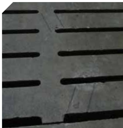
Un marquage permanent au sol permet de placer les panneaux parfaitement
