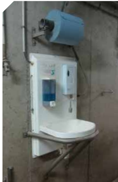
Le distributeur de papier essuie-mains et la poubelle doivent être positionnés à proximité du lave-mains
