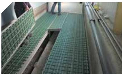
Les cloisons se rangent sur des supports fixés au mur, et des caillebotis viennent reboucher la fosse
