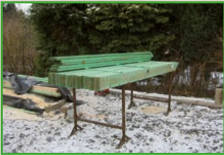
Stockage de madriers à bonne hauteur
