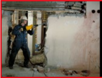
Marteau-piqueur manipulé par le travailleur (risque important en raison des vibrations et du poids de l'engin)
