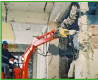
Marteau-piqueur manipulé par le travailleur (risque important en raison des vibrations et du poids de l'engin)
