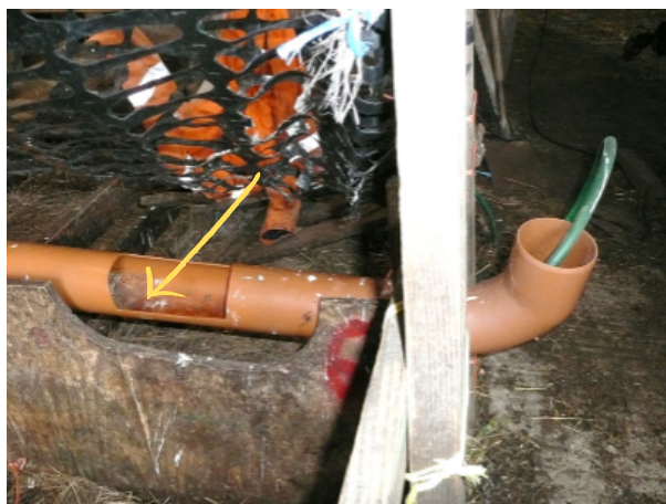
Case en construction
